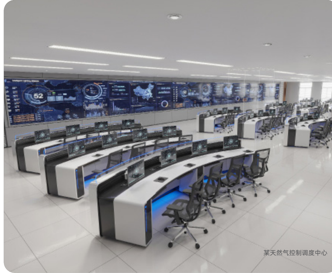
国家电网某电力调度控制中心
